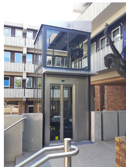
Nouvel ascenseur au collège Paul-Landowski à Boulogne-Billancourt - © CD92
