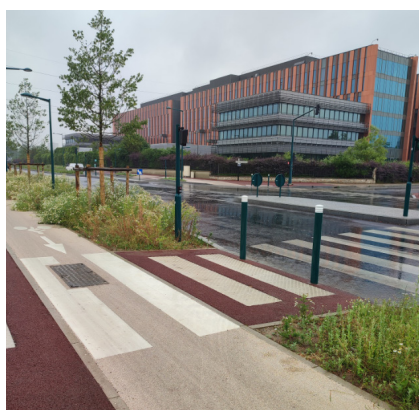
Les noues de l'avenue Marcel Paul à Gennevilliers (RD911) - © CD92
