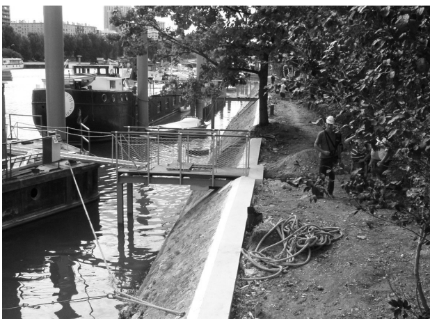
Berges de l'île de Monsieur en cours d'aménagement (Source CG92)
