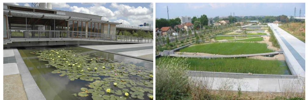
Vue des bassins filtrants (Source : A. Petzold / W. Labre)
