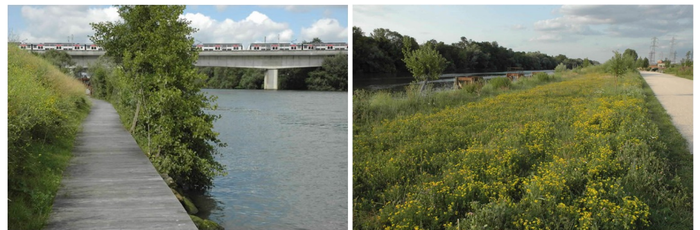
Vue des berges réhabilités après travaux (Source : A. Petzold / W. Labre)
