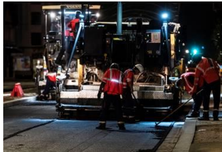
Travaux d'enrobés sur la RD906 à Clamart
