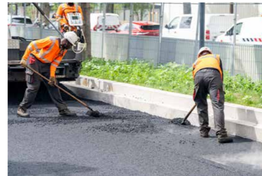
▲ Aménagement de l'avenue Sully-Prudhomme (RD 67) à Châtenay-Malabry (6,55 millions d'euros sont dédiés à ce projet). Pour cette nouvelle chaussée, le Département utilise un enrobé « vert » avec des granulats recyclés à hauteur de 70 % et un liant d'origine végétale. © CD92/Olivier Ravoire
