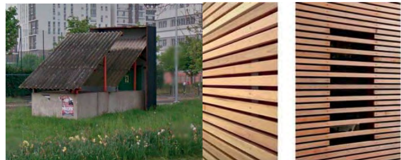
Figure 13 : Etat actuel de l'édicule de secours de l'A 14 et exemple de bardage en bois
