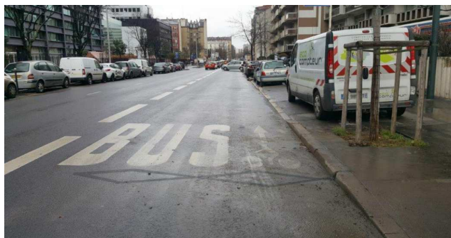
Boucle installée dans le couloir bus de la RD 19 à Clichy
