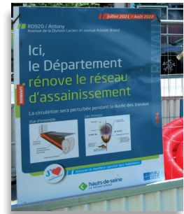
Panneau de chantier pédagogique d'assainissement.
