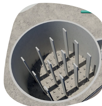
Réalisation d'un bassin de stockage des eaux pluviales (Issy-les-Moulineaux)
