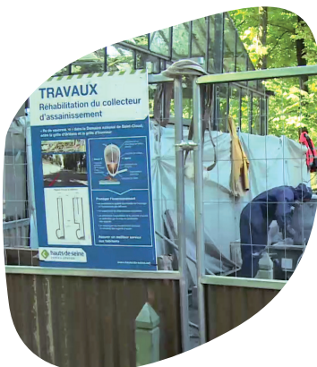
Réhabilitation d'un collecteur visible (Vaucleross)
