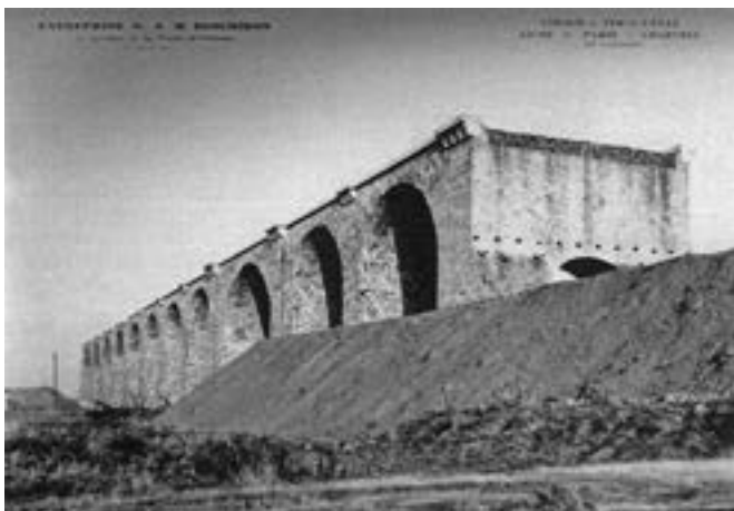
Construction d'ouvrages pour la ligne : le viaduc de la Bièvre (1932) ; extrait étude GRAHAL (source mairie Antony)
