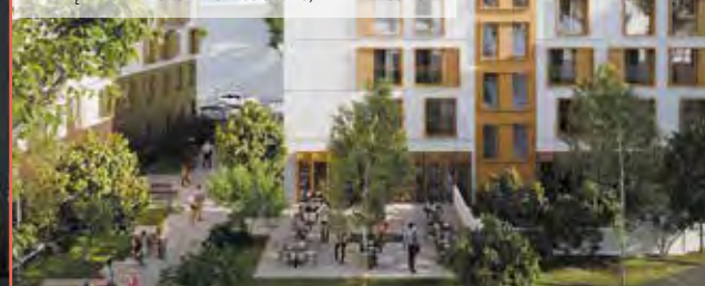
Pôle intergénérationnel Barbusse © Quadri Fiore Architecture, MZH Atelier
