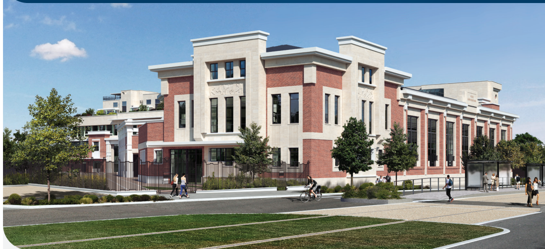
Vue du nouvel établissement scolaire, Claude-Nicolas Ledoux, au Plessis-Robinson.
