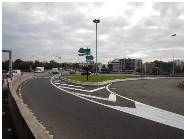
Figure 14 : sortie de l'A13 (à gauche direction pont de St Cloud, à droite direction RD 7)
