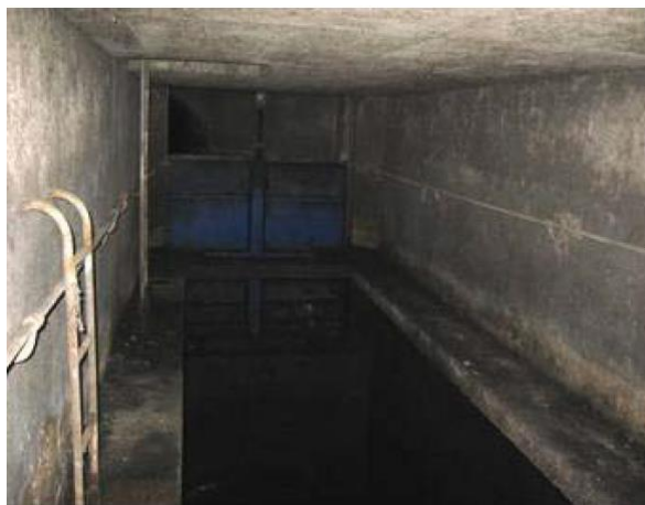
Figure 89 : vue intérieure de la chambre à sables SCL-07
