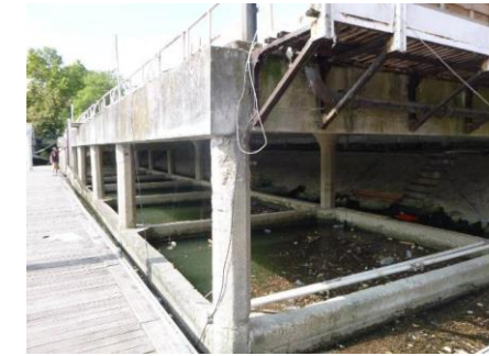
Figure 94 : estacade au niveau du Port Surena
