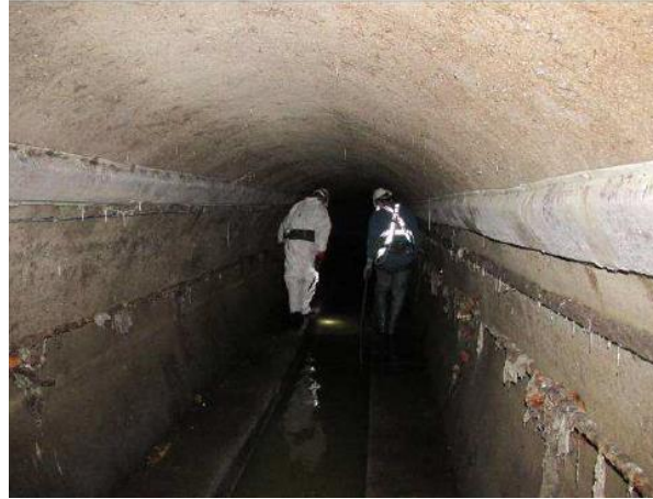
Figure 87 : vue générale du collecteur
