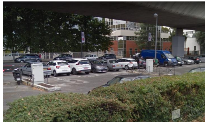
Figure 90 : vue en surface des chambres SCL-06 et SCL-07
