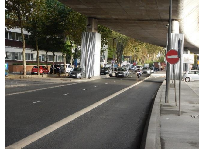
Figure 7 : chaussée de la RD 7 dans le sens Nord-Sud
