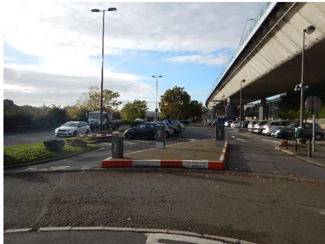
Figure 38 : parking aérien payant entre les deux sens de circulation du Quai du Président Carnot
