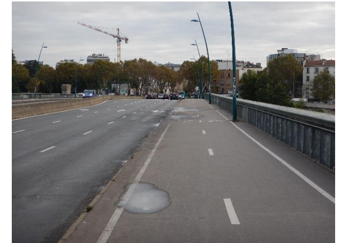
Figure 17 : pont de Saint-Cloud – chaussée et trottoir sud
