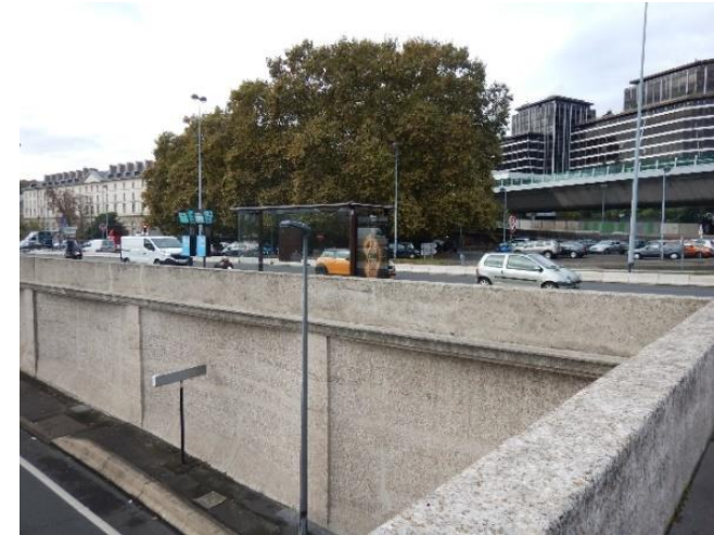
Figure 79 : square masquant l'entrée du parc de Saint-Cloud
