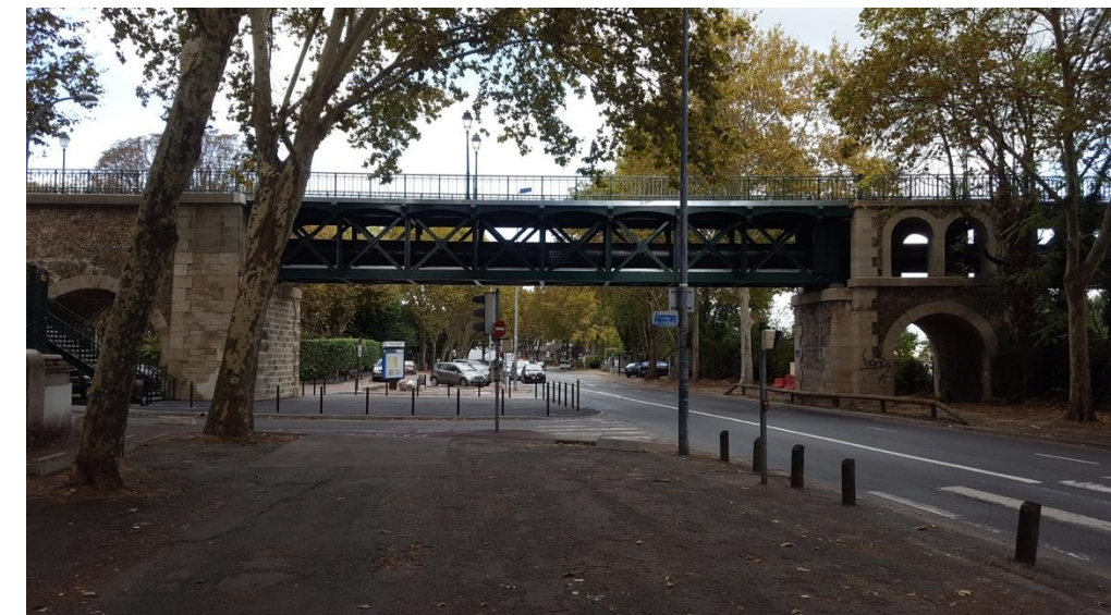
Figure 101 : passerelle de l'aqueduc de l'Avre
