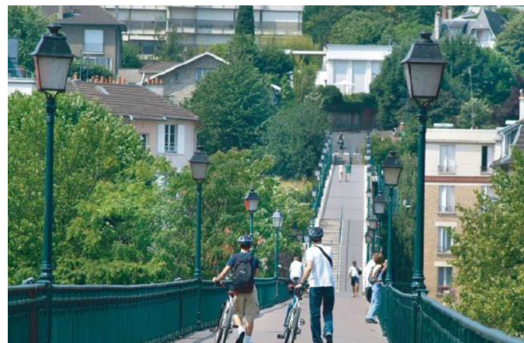
Figure 162 : Passerelle de l'Avre (PLU de Saint-Cloud)
