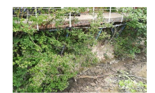
Figure 97 : encorbellement pour stationnement au droit de l'avenue de l'Aqueduc
