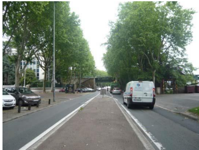
Figure 5 : chaussée de la RD 7 au sud de la passerelle de l'aqueduc de l'Avre
