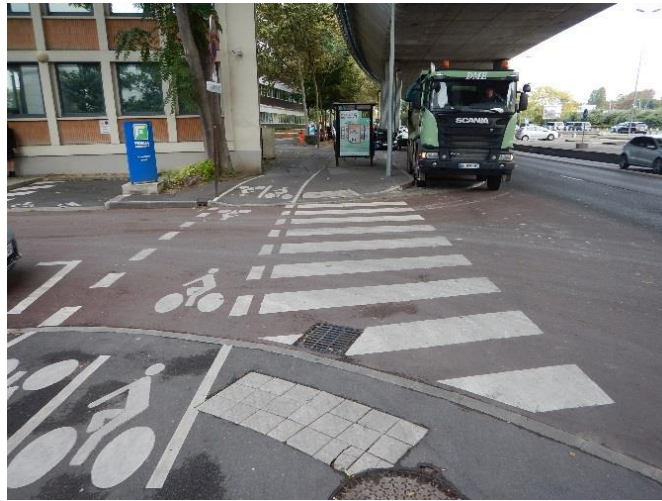
Figure 163 : Traversée cyclistes sur la RD7 au niveau de l'avenue Eugénie (CD92)
