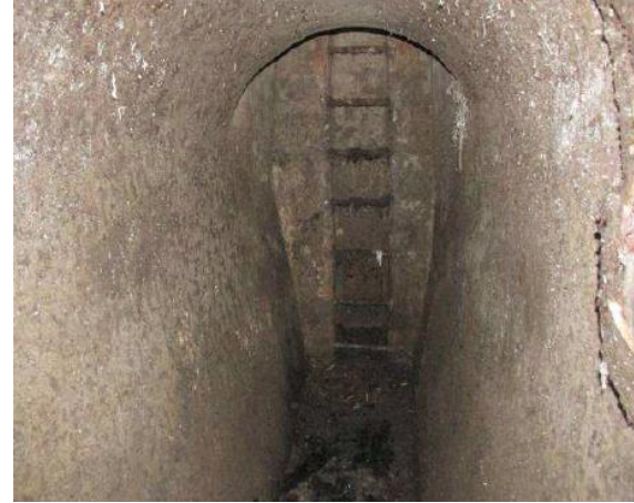
Figure 88 : galerie de regard d'accès
