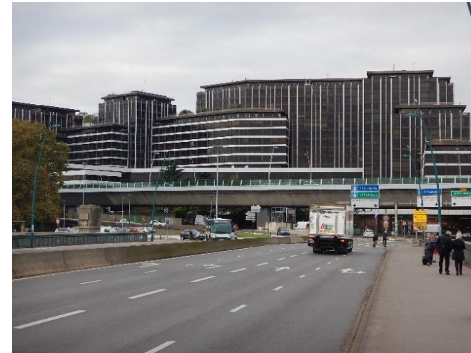
Figure 16 : pont de Saint-Cloud - chaussée et trottoir nord
