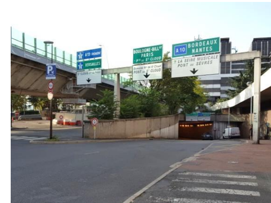
Figure 11 : entrée du tunnel routier de la place Clemenceau
