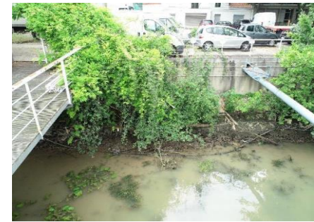
Figure 96 : soutènement de trottoir et stationnement entre la rue de la Verrerie et l'avenue de l'Aqueduc
