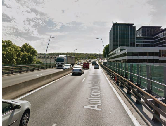
Autoroute A13 à Saint-Cloud : Voie circulée avant la bretelle d'insertion
