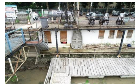
Figure 98 : estacade avec abri souterrain au niveau de la Marina de l'Ave
