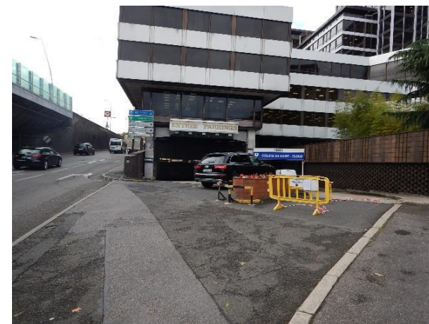
Figure 42 : entrée du parking souterrain « Colline de Saint-Cloud »
