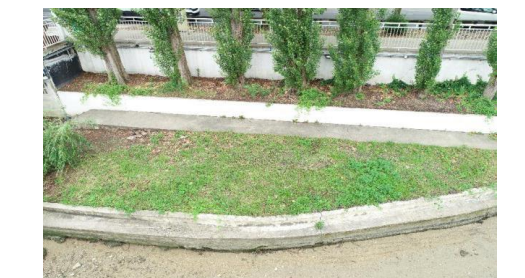
Figure 99 : trottoir et soutènement avec abri souterrain en amont de l'avenue des Pâtures
