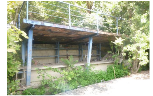
Figure 95 : encorbellement au droit de la rue de la Verrerie
