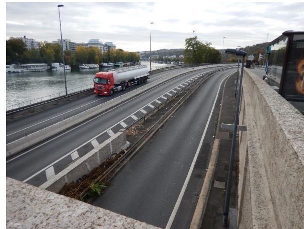
Figure 20 : passage sur berges de la RD 7 (vu depuis le pont de Saint-Cloud)
