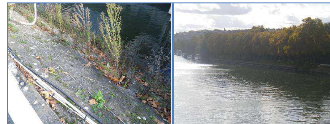
Figure 106 : Photographies des berges bétonnées (à gauche) et associées à des palplanches (à droite) au droit de la Seine à Suresnes. (Source : © A. Desnos, SARL Pedon Environnement & Milieux Aquatiques, 5/11/2017)
