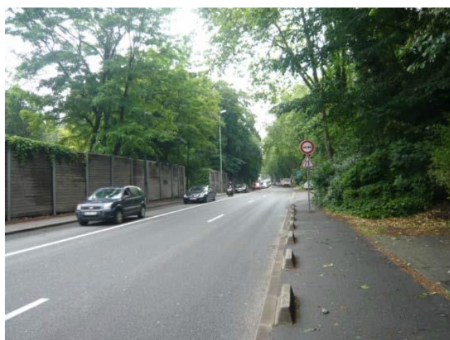
Figure 35 : dispositifs anti-stationnement (à Suresnes sur la photo)
