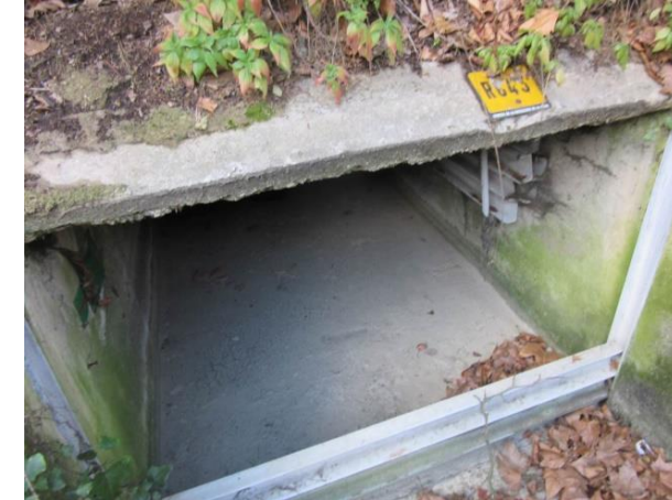
Figure 91 : vue de l'Exutoire en Seine du DO G13 avec 3 poutrelles
