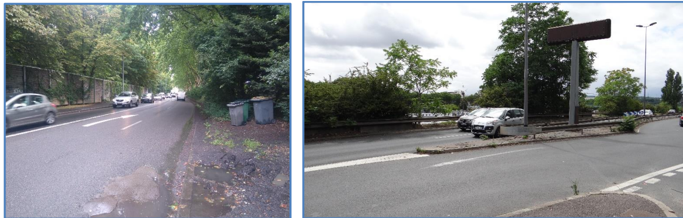
Figure 115 : A gauche : RD7 au niveau du quai Léon Blum, à droite : R7 au niveau du quai du Président Carnot (Egis, 2017)
