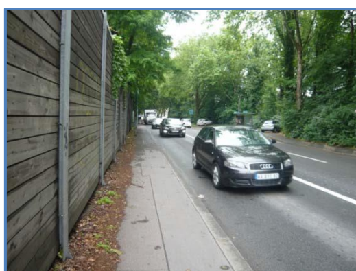
Figure 83 : Quai Léon Blum au niveau du Parc de Château (CD92)
