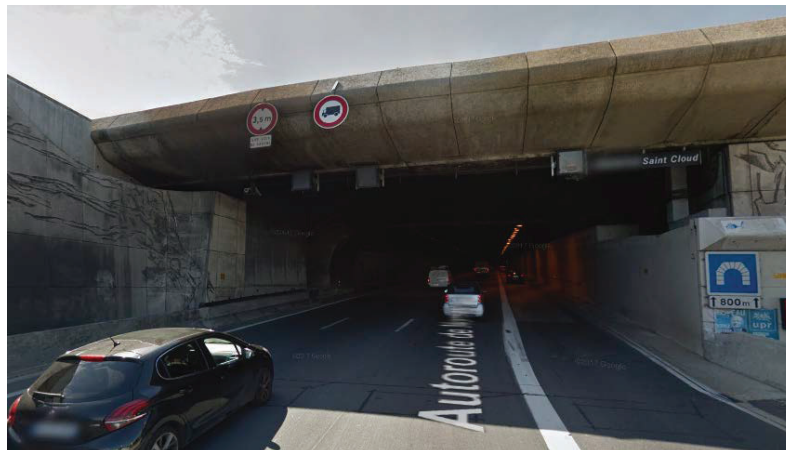
Autoroute A13 à Saint-Cloud : Elargissement après la bretelle d'insertion (voie d'insertion à droite)
