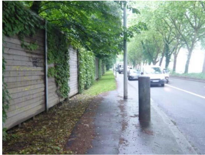
Figure 52 : trottoir au niveau du parc du Château
