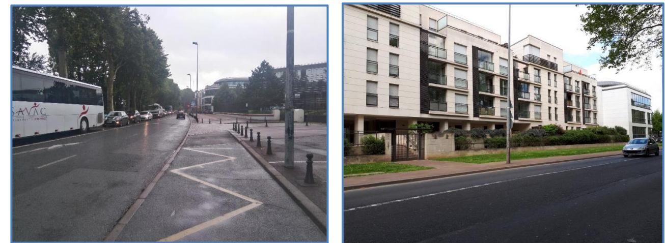
Figure 116 : Abords de la RD7 (Egis, 2017)
