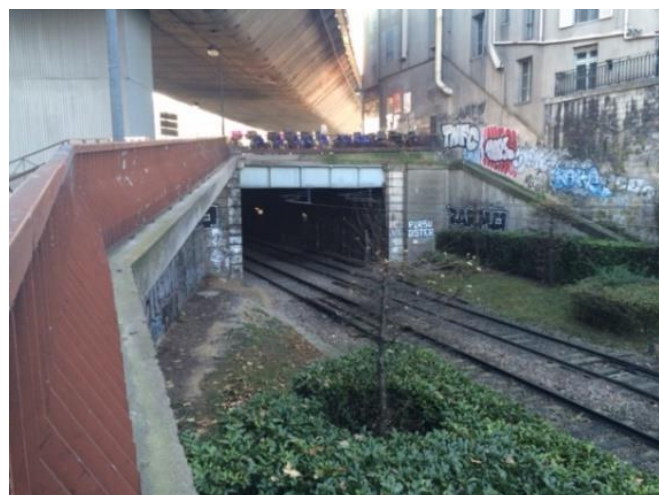
Figure 102 : Passage du tramway T2 sous la place Clemenceau (trémie nord)
