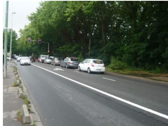
Figure 3 : chaussée de la RD 7 en section courante à Suresnes
